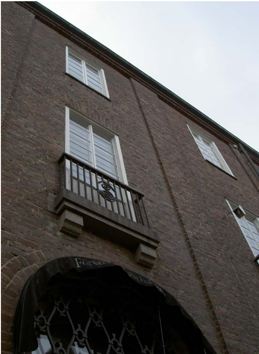
Sparbanken i Umeå. Utsnitt av västra fasaden.
